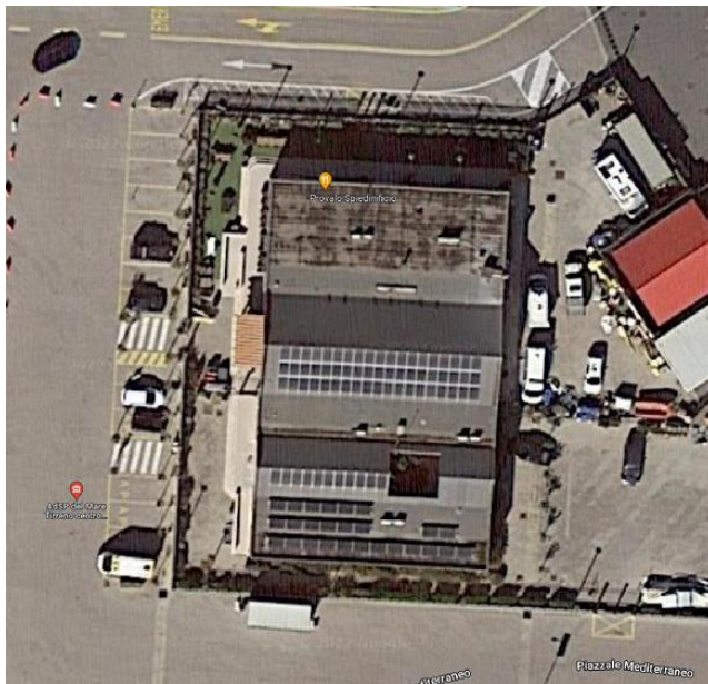
Figura 8: Impianto PV AdSP Porto Fiumicino (FCO)
