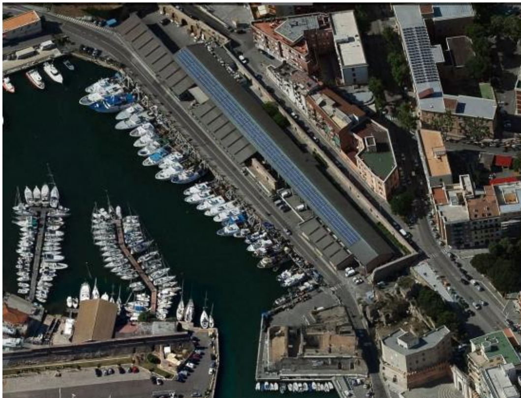
Figura 3: Impianto PV Darsena Romana (CV)
